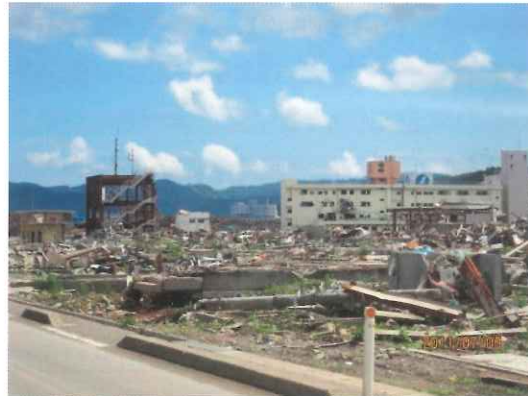
右が4階まで津波が来た志津川病院。 左が鉄骨だけになった防災対策庁舎。 4ヶ月経つてもガレキが片付かない
